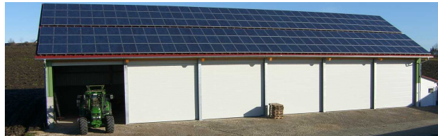
Maschinenhalle mit Photovoltaikanlage Schöndienst, Trossingen – Schura
