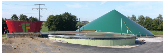
Biogasanlage Helmut Schaff, Tuningen
