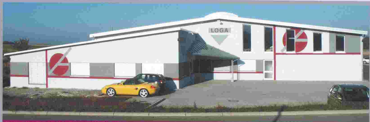
Neubau Firmengebäude Fa. Loga Präzisionsteile in Denkingen
