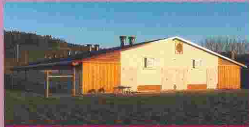
Legehennenstall für Bodenhaltung Matthias Höhle, Geislingen-Binsdorf
