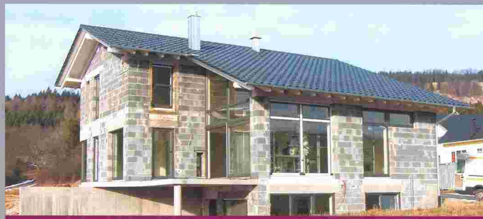
Wohnhaus Neubau Familie Ohlhauser in Wehingen
