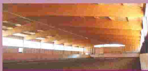
Reithalle Wenigsbronner Hof, Tuttlingen
