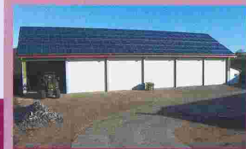
Satteldach-Bergehalle mit Photovoltaik-Anlage Schöndienst, Schura
