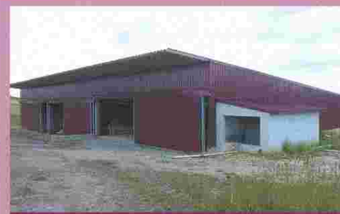
Bergehalle als kostengünstiges Pultdach
