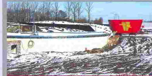
Fermenter mit Betondecke 1.200 m 3 , Nachgärer 2.000 m 3 und Vorgube mit 60 m 3 Inhalt. In die bestehende Bergehalle wurden die Räume für das Block-Heiz-Kraft-Werk und die Technik eingebaut.
